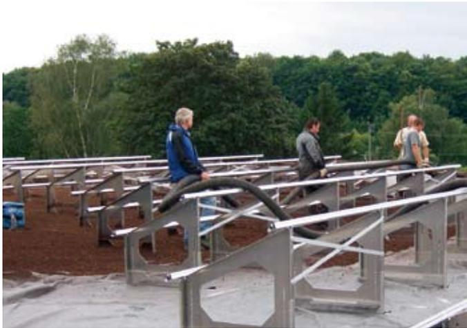
Das Pflanzsubstrat wird vom Lkw direkt auf das Dach gepumpt.
