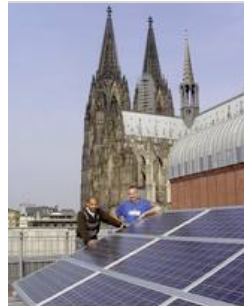
Bauleiter Adam Altfati (l.) und Projektleiter Christoph Goedecke (r.) von Energiebau auf der Dachterrasse des Museum Ludwig in Köln.
